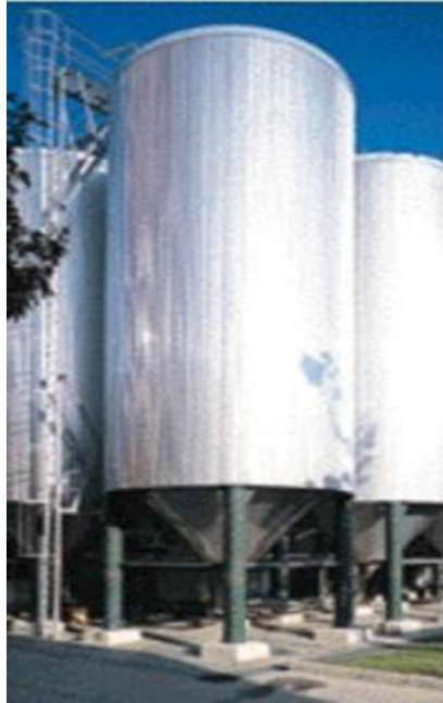
Slika 3. Cilindrično-konusni fermentori (CKF)
