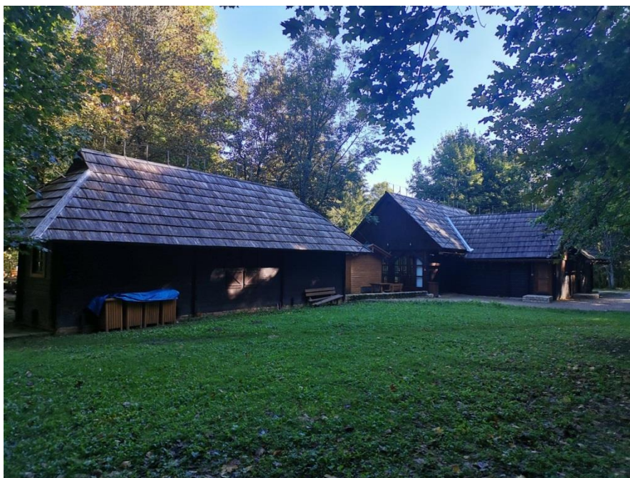
Slika 5 - Restoran „Labudovac“ gledan sa zadnje strane od strane prometnice
