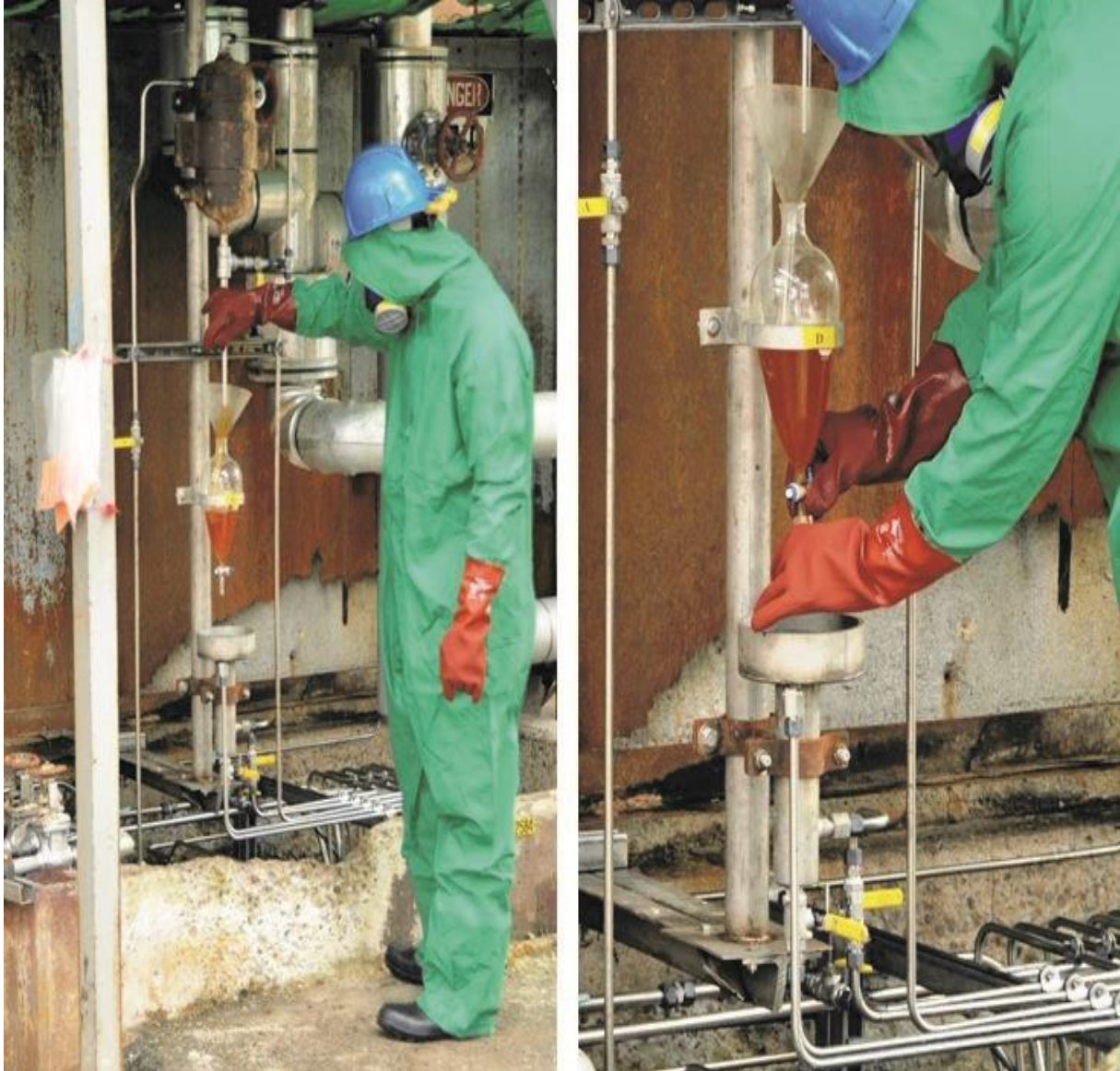
Slika 7: Fotografije operatera u rafineriji Tesoro Martinez koji uzima uzorak sumporne kiseline. Ove fotografije snimljene su nakon incidenta 12. veljače 2014. s novim zahtjevima za zaštitu osobnih podataka. Tesorovom sustavu za uzorkovanje sumporne kiseline potrebna su dva odvojena jednosatna čekanja kako bi se ugljikovodici mogli otpustiti u atmosferu. Uz potencijalno izlaganje tekućoj kiselinu, postupak uzorkovanja izlaže operatera ugljikovodičnim parama i parama sumporne kiseline. Nakon incidenta Tesoro je nadgradio zahtjeve za zaštitu osoblja koji su uključivali respirator i zaštitno odijelo za cijelo tijelo. [Proces safety culture case study Martinez, California, No. 2014-02-I-CA]
