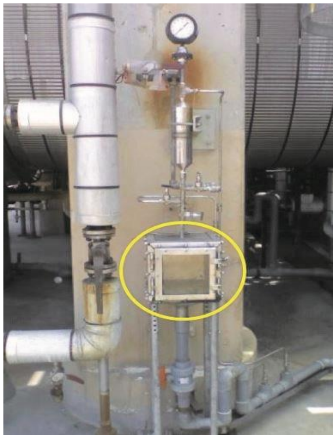
Slika 9: Fotografija uzorka sumporne kiseline u rafineriji Tesoro u Los Angelesu. Ovaj sustav uzorka uključuje kućište na mjestu uzorka radi zaštite operatera od potencijalnog prskanja kiselinom. [Proces safety culture case study Martinez, California, No. 2014-02-I-CA]
