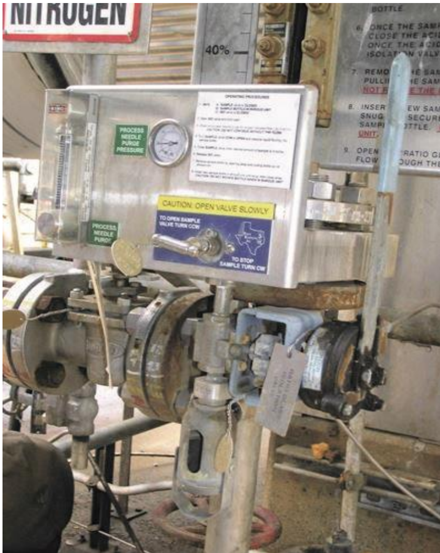
Slika 8: . Fotografija prikazuje jednu od nadograđenih stanica za uzorke koje je Tesoro instalirao radi smanjenja izloženosti operatera kiseline tijekom uzorkovanja. Tesoro nikada nije riješio pitanja pouzdanosti s tih stanica i stanice su stavljene van uporabe. Kao rezultat toga, one nisu bile u uporabi u vrijeme incidenta 12. veljače 2014. godine. [Proces safety culture case study Martinez, California, No. 2014-02-I-CA]
