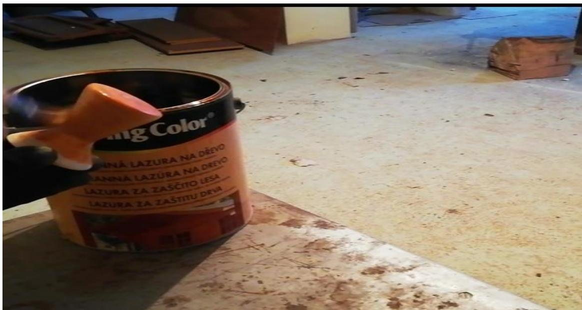
Slika 37. Premazivanje obradka sa lazurom za zaštitu drva
