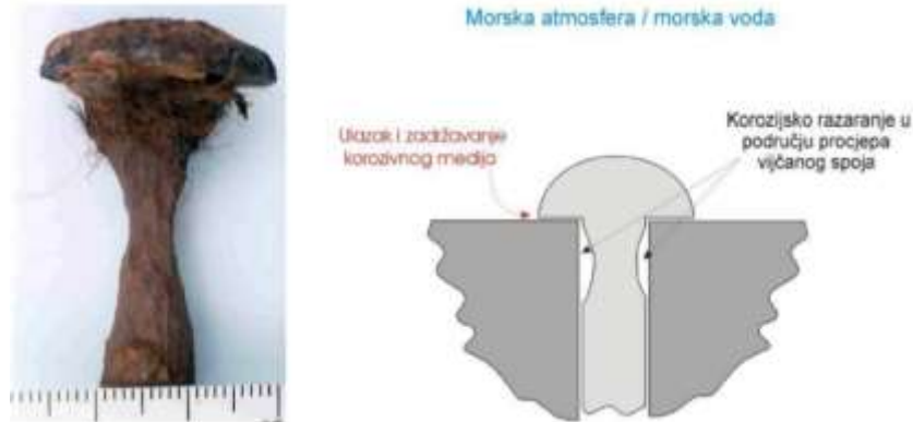
Slika 6. Korozijska oštećenja čeličnog vijka za učvršćivanje broskog motora (lijevo) i shema mehanizma oštećivanja u području procjepa vijčanog spoja (desno) (Alar, 2015.).
