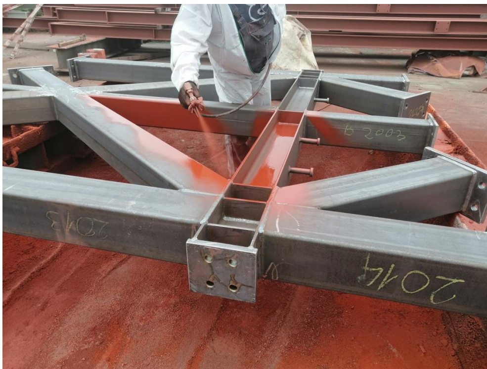
Slika 62. Zaštita izvedenih sklopova bojom
