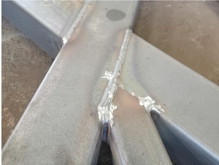
Slika 60. Zavar sklopa kvadratnih cijevi
