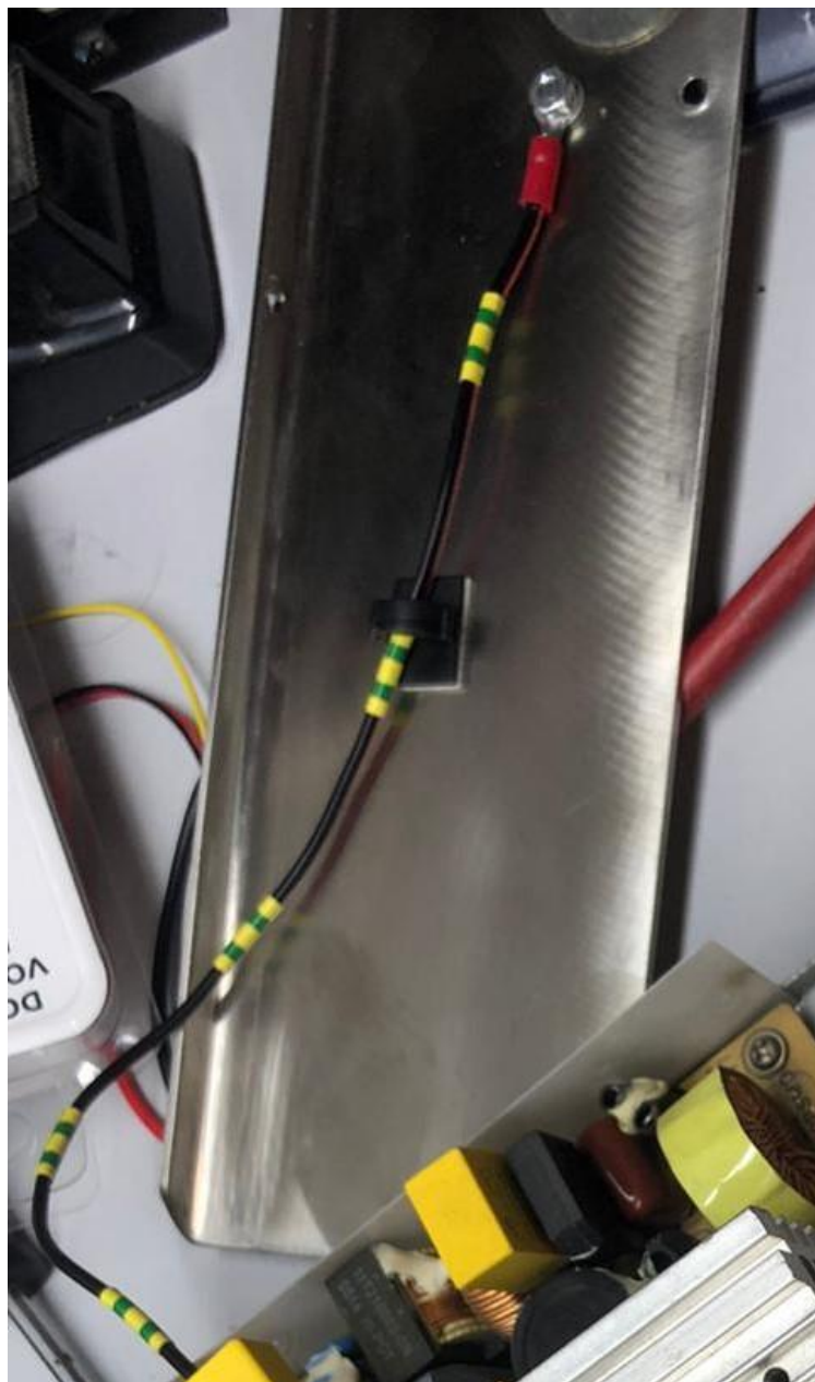
Slika 28. Provedba uzemljenja kućišta
