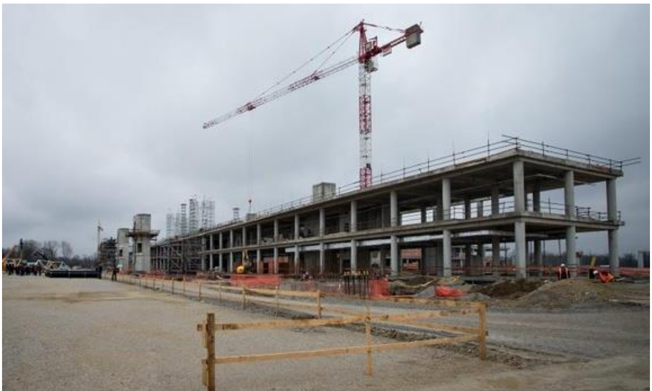
Slika 3. Izgradnja terminala zračna luka Zagreb
