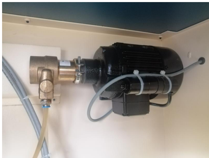
Slika 9 Jedinica za stvaranje podtlaka
