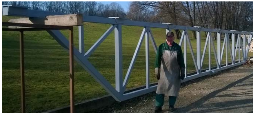
Slika 10. Rešetkasti nosač krovne konstrukciju kinodvorane, 28.01.2016, Donja Stubica
