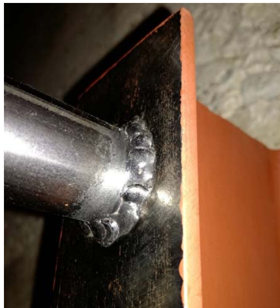
Slika 18. Zavar konzole sa MAG postupkom
