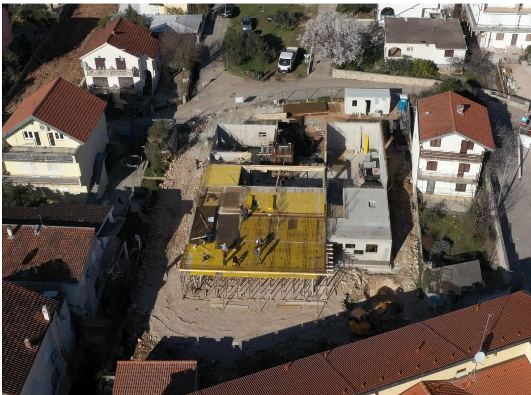
Slika 2. Primjer uređenog gradilišta sa pristupnim putevima (DV „Mendula“, Pirovac) [2]
