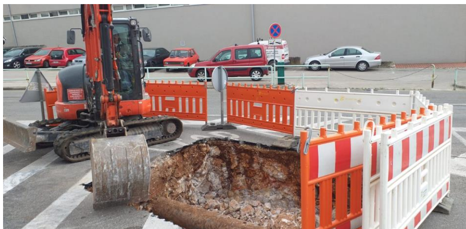
Slika 8.: Pravilno osiguranje gradilišta kod zemljanih radova [8]
