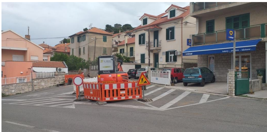
Slika 7.: Pravilno osiguranje gradilišta kod zemljanih radova [7]
