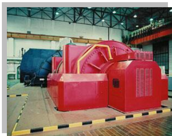
Slika 8. Hidrogeneratori
