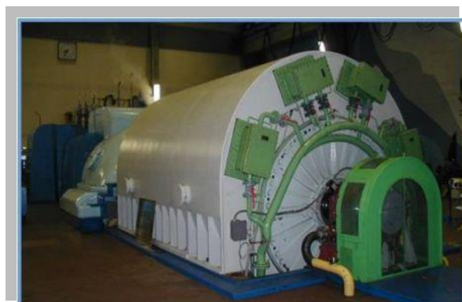
Slika 8. Hidrogeneratori
