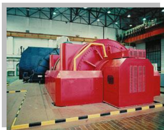
Slika 8. Hidrogeneratori
