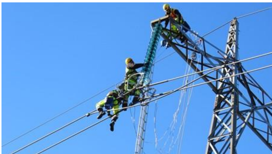
Slika 1.Radnici rade na postavljanju dalekovoda
