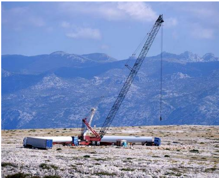
Slika 8.1 Dizanje stupova
