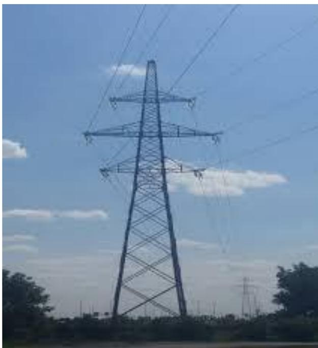
**Slika.2.1.** jednostruko čelično-rešetkasti stup "jela"
