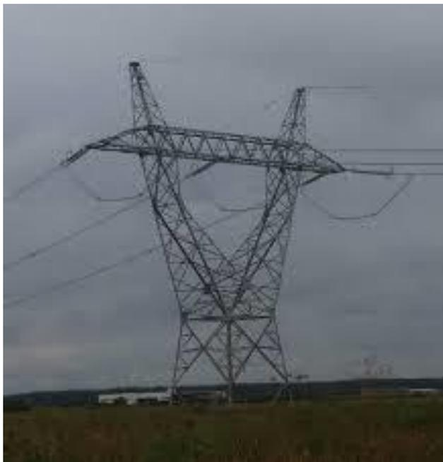
**Slika.2.2.** Jednostruko čelično-rešetkasti stup " Y-stup"
