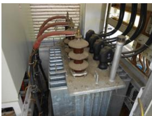
Slika 13. Čišćenje TS metodom (prije)
