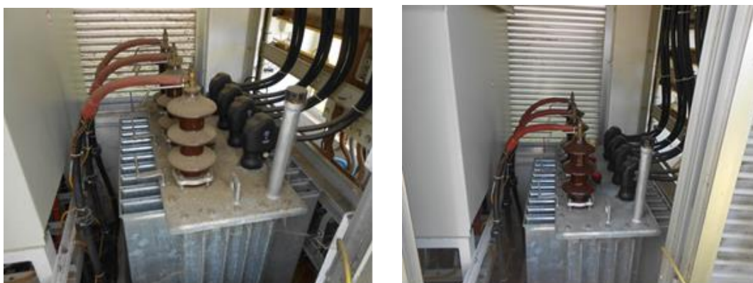
Slika 13. Čišćenje TS metodom (prije)
