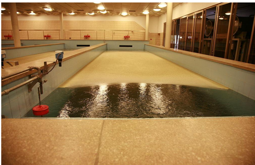
Slika 3. Veliki filter za procjeđivanje pitke vode.
