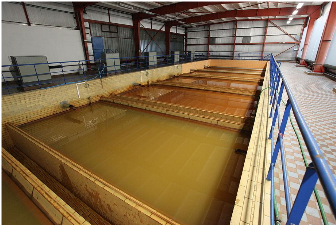
Slika 7. Bazeni s taložnicama za pijesak za uklanjanje željeza.
