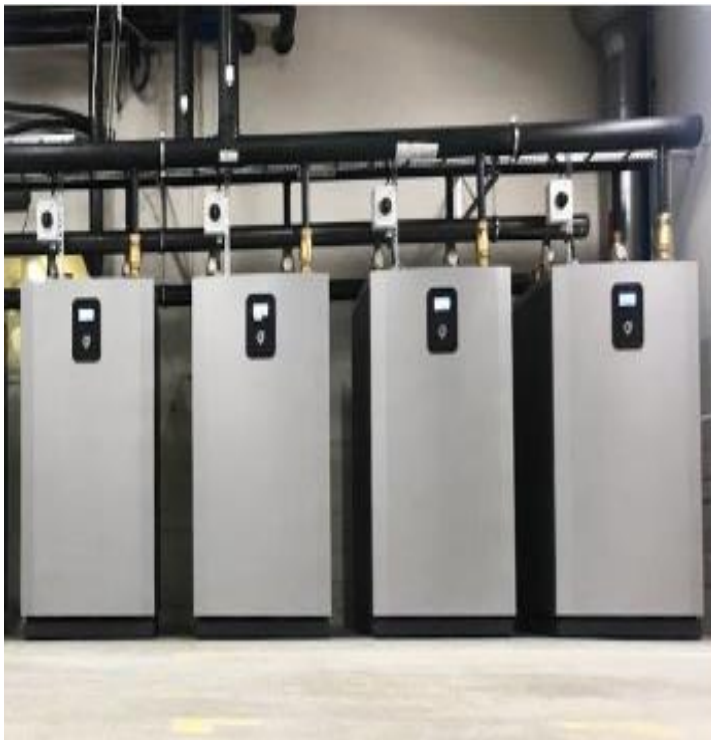
Slika 6.23. Dizalica topline Thermia MEGA XL [16]
