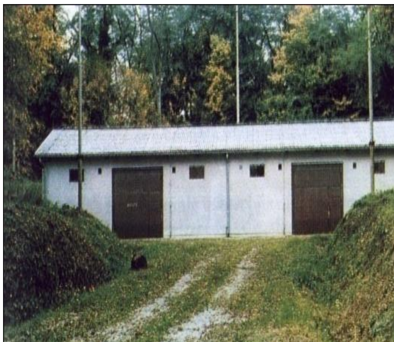
Slika 7. Nadzemni skladišni objekt za smještaj i čuvanje eksplozivnih sredstava vrste S [3]
