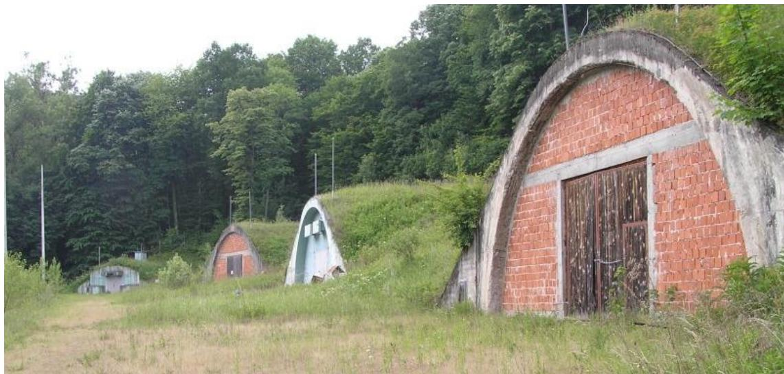
Slika 3. Nadzemni skladišni objekt za smještaj i čuvanje eksplozivnih sredstava vrste PU
