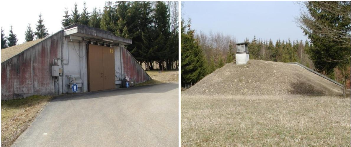
Slika 5. Nadzemni skladišni objekti za smještaj i čuvanje eksplozivnih sredstava vrste IGLO [3]
