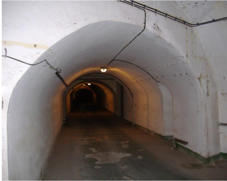
Slika 8. Podzemno skladište eksplozivnih sredstava tunelskog tipa s više komora [3]
