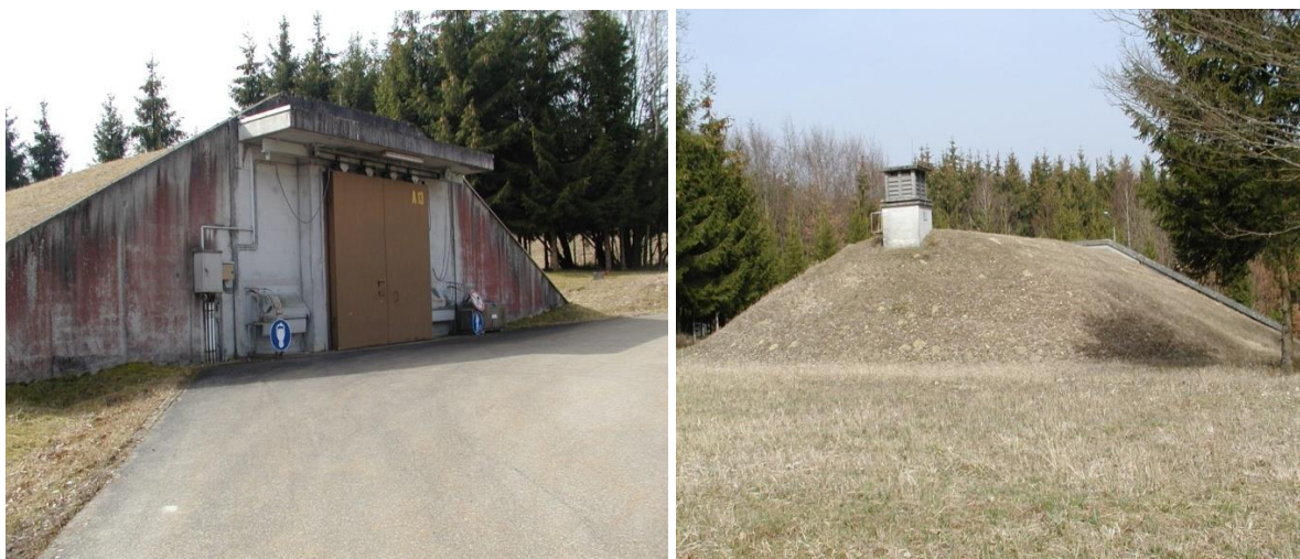
Slika 5. Nadzemni skladišni objekt za smještaj i čuvanje eksplozivnih sredstava vrste IGLO [3]
