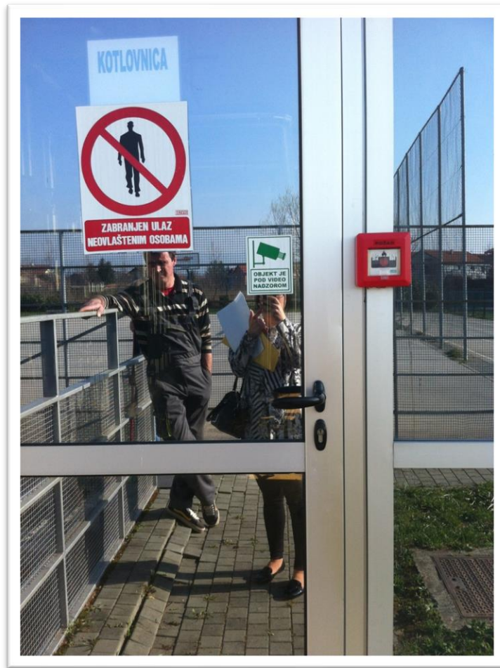
Slika 9: Ulaz u kotlovnicu s pripadajućim oznakama obavijesti i upozorenja, vlastiti izvor
