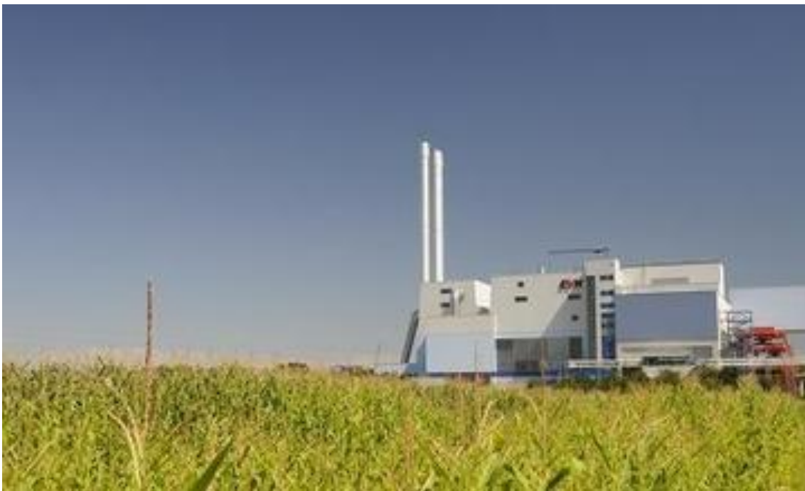
Slika 6. Energana za spaljivanje plastike
