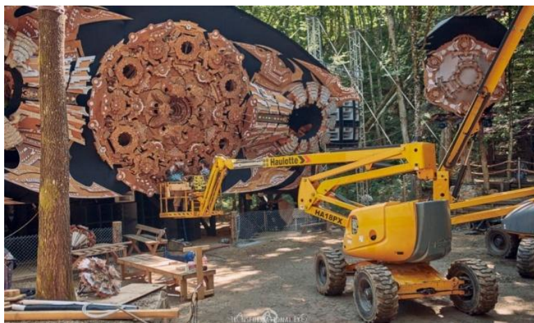
Slika 8: Izgradnja glavne pozornice
