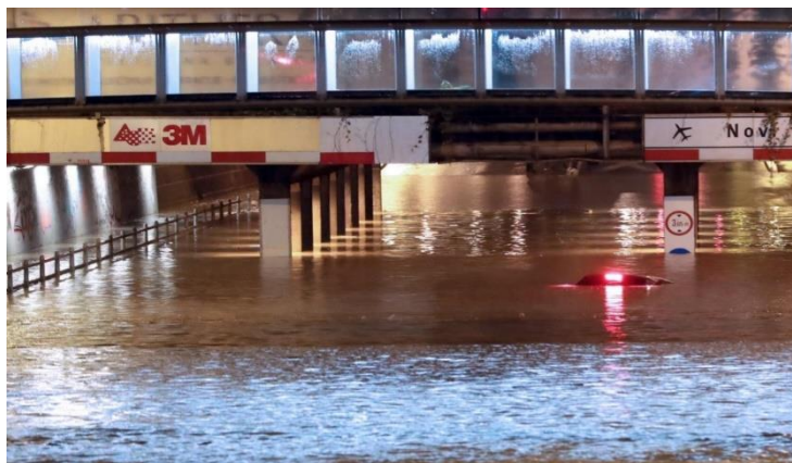
Slika 4. Poplavljen podvožnjak u Zagrebu, onemogućuje prolaz vatrogascima [11]
