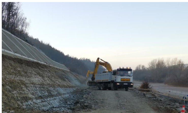
Slika 26.d Utovar kamiona kipera bagerom
