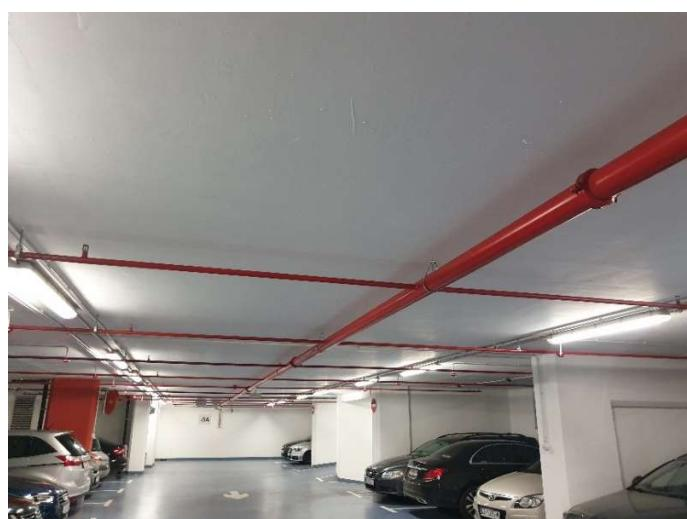
Slika 10. Automatske sprinkler instalacije u garaži HEP-a [13]
