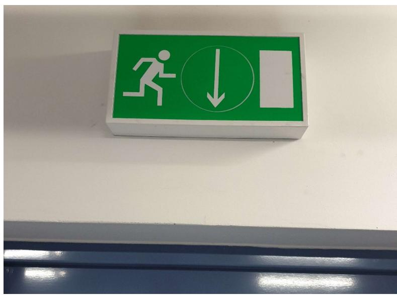
Slika 13. Protupanična rasvjeta sa pripadajućim piktogramom u novoj upravnoj zgradi HEP-a [13]
