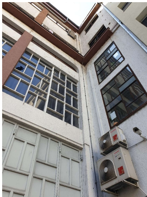
Slika 15. Gromobranska instalacija na zgradi 'Instituta' [13]
