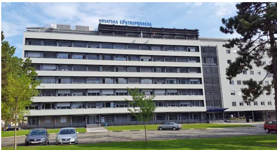
Slika 1. Kompleks zgrada Hrvatska elektroprivreda [1]
