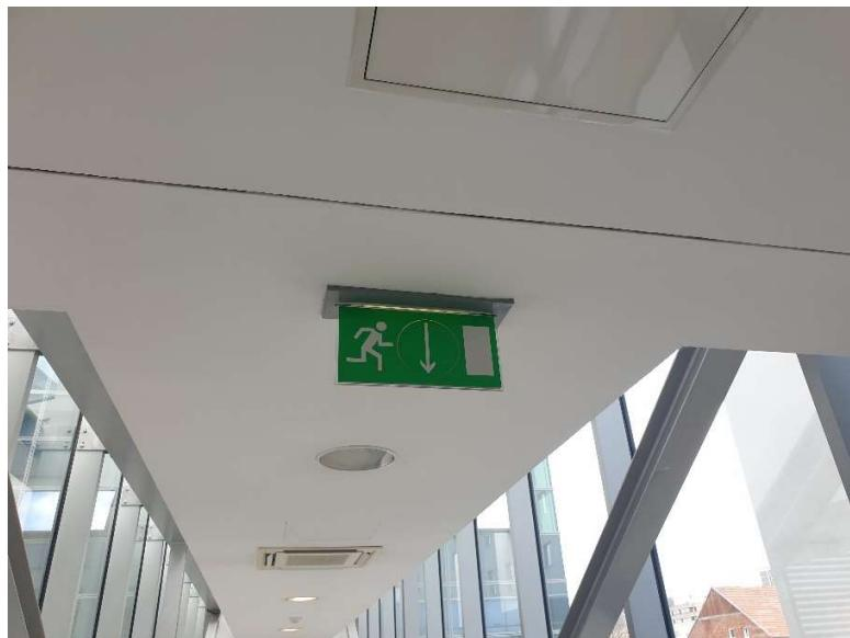
Slika 12. Protupanična rasvjeta sa pripadajućim piktogramom u novoj upravnoj zgradi HEP-a [13]
