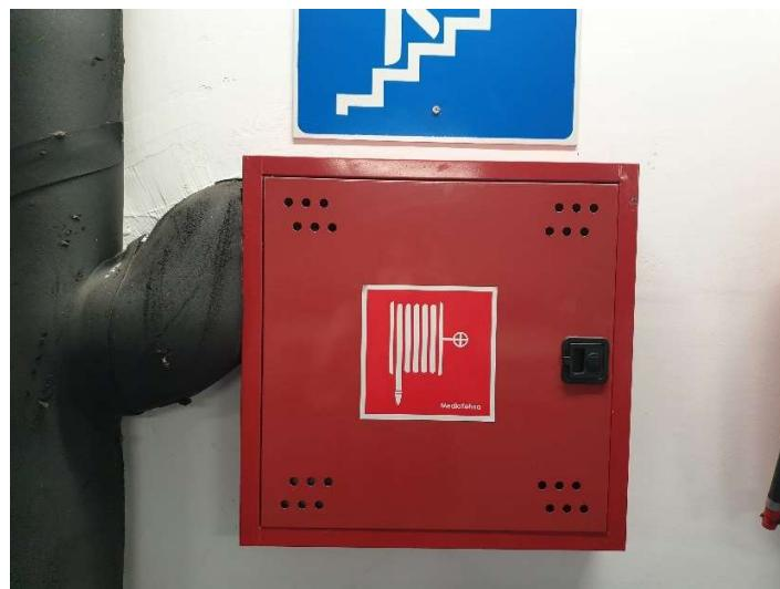
Slika 14. Unutarnji hidrant priključen na hidrantsku mrežu u garaži HEP-a [13]
