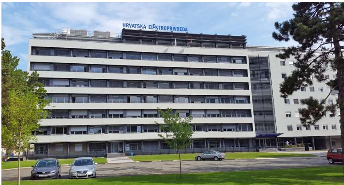
Slika 1. Kompleks zgrada Hrvatska elektroprivreda [1]
