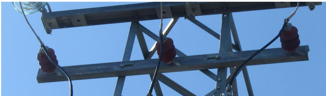
Slika 17 Ugrađeni Raychem odvodnici prenapona na čelično-rešetkastom stupu
