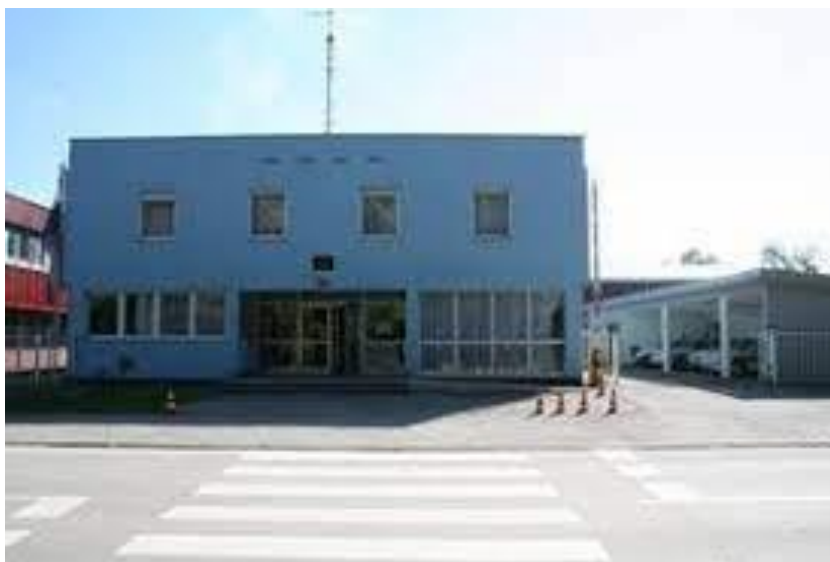
Slika 13. Zgrada Policijske postaje A [20]
