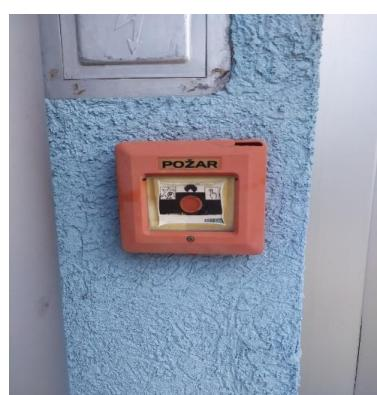
Slika 15. Ručni javljač požara. (Izvor: autor)
