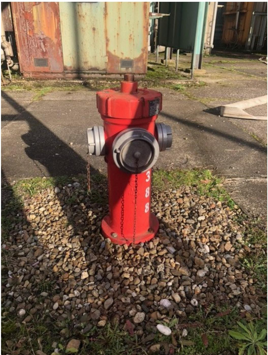
*Slika 3. Visoko tlačni nadzemni hidrant [7]*
