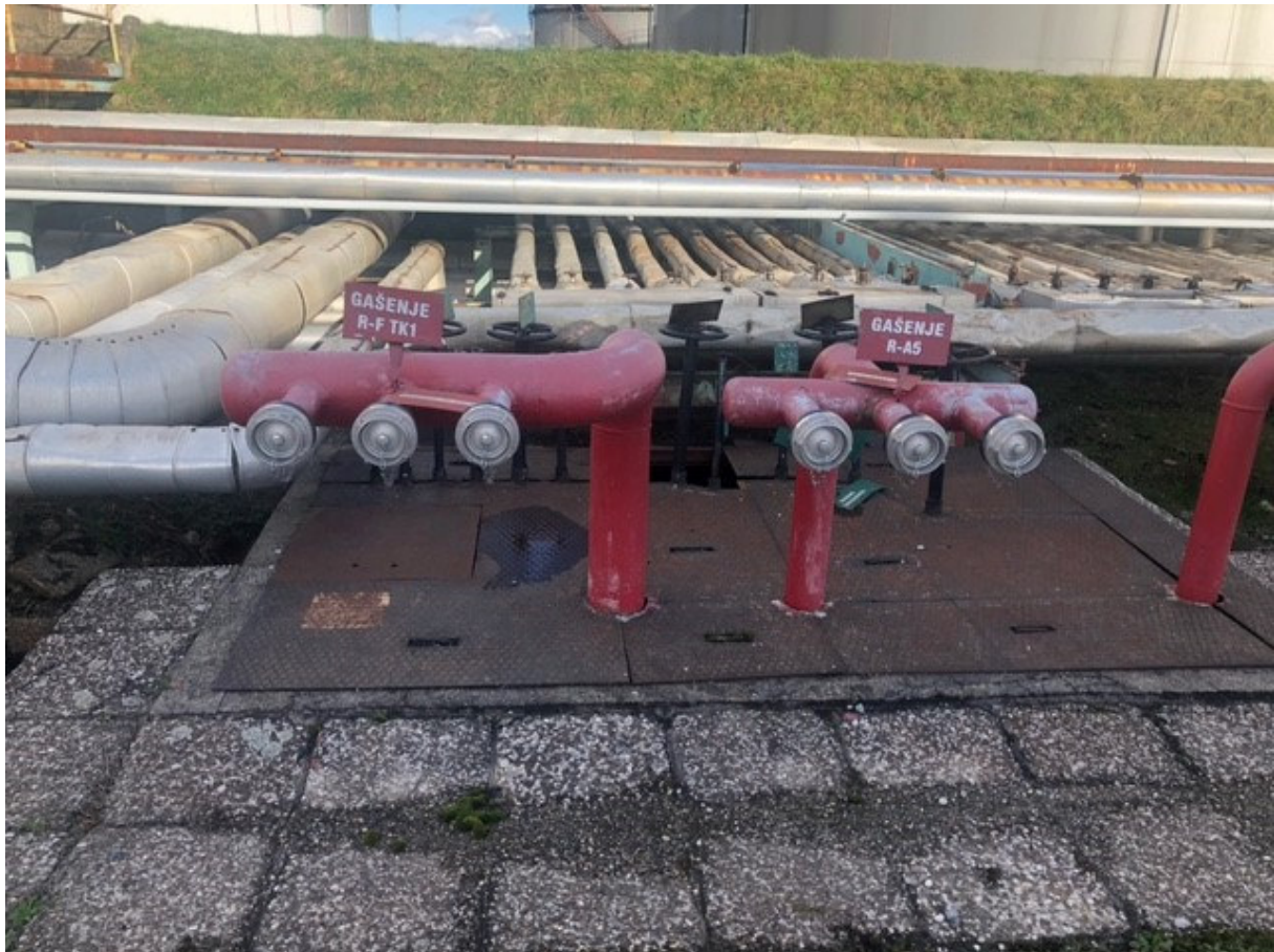
Slika 6. Polustabilni sustav za gašenje spremnika [7]
