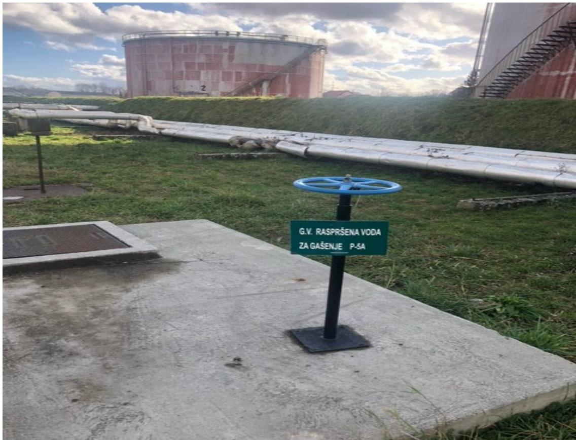
Slika 9. Glavni ventil za ručno otvaranje drencher sustava [7]
