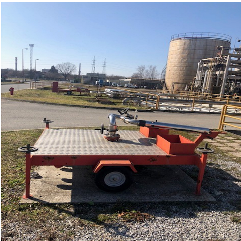
Slika 14. Mobilni bacač voda/pjena tip "Juring" na KP-6 [7]
