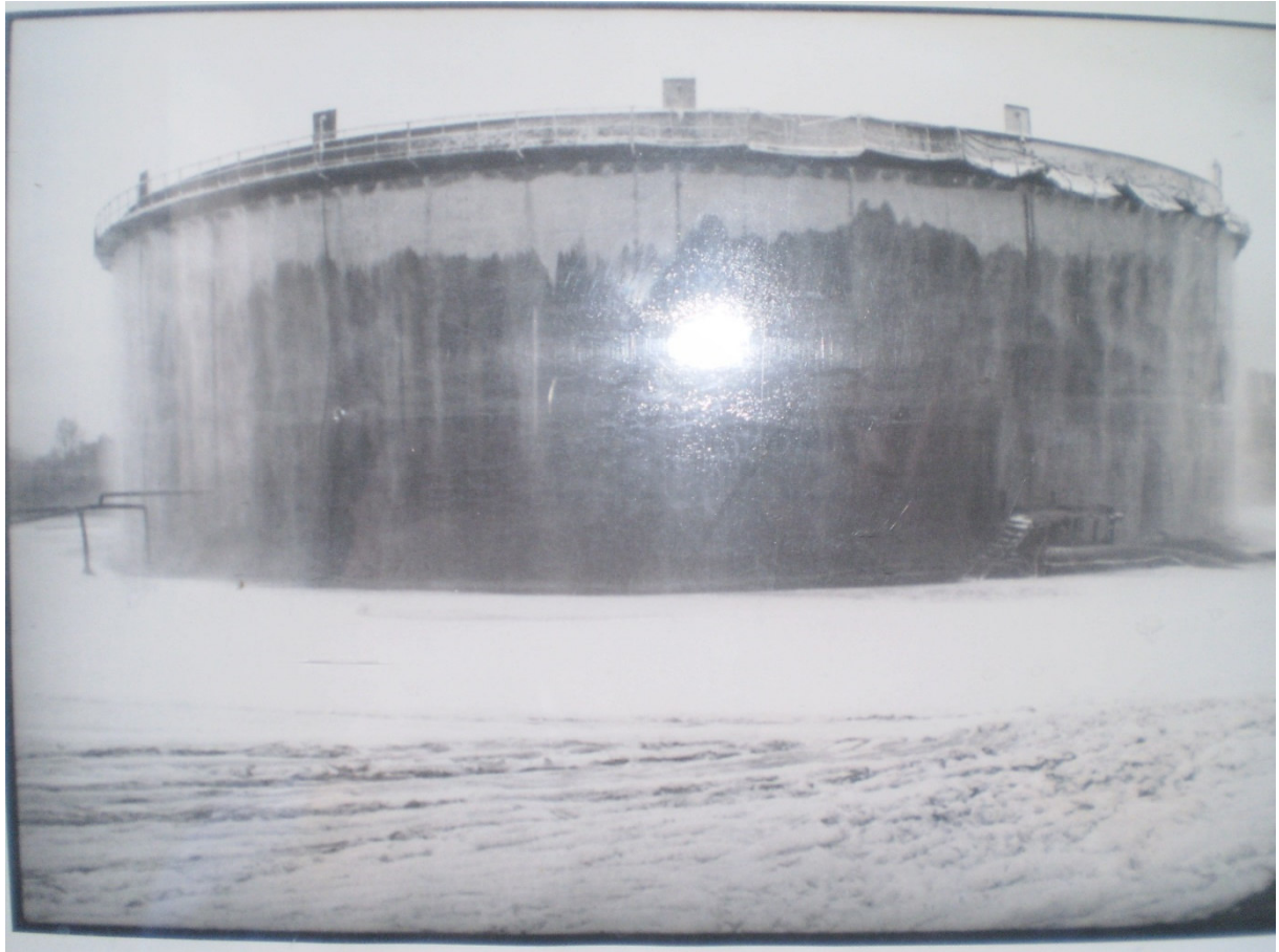
Slika 24. Spremnik R-802 nakon gašenja [7]
