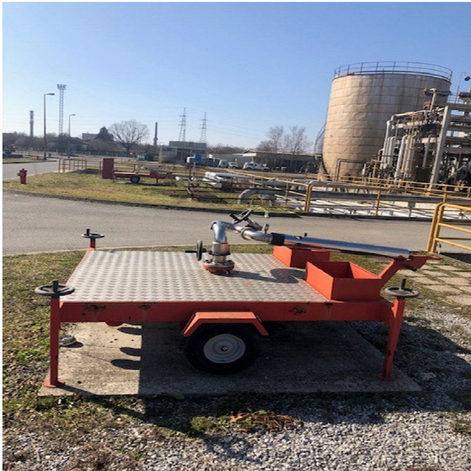
Slika 14. Mobilni bacač voda/pjena tip "Juring" na KP-6 [7]
