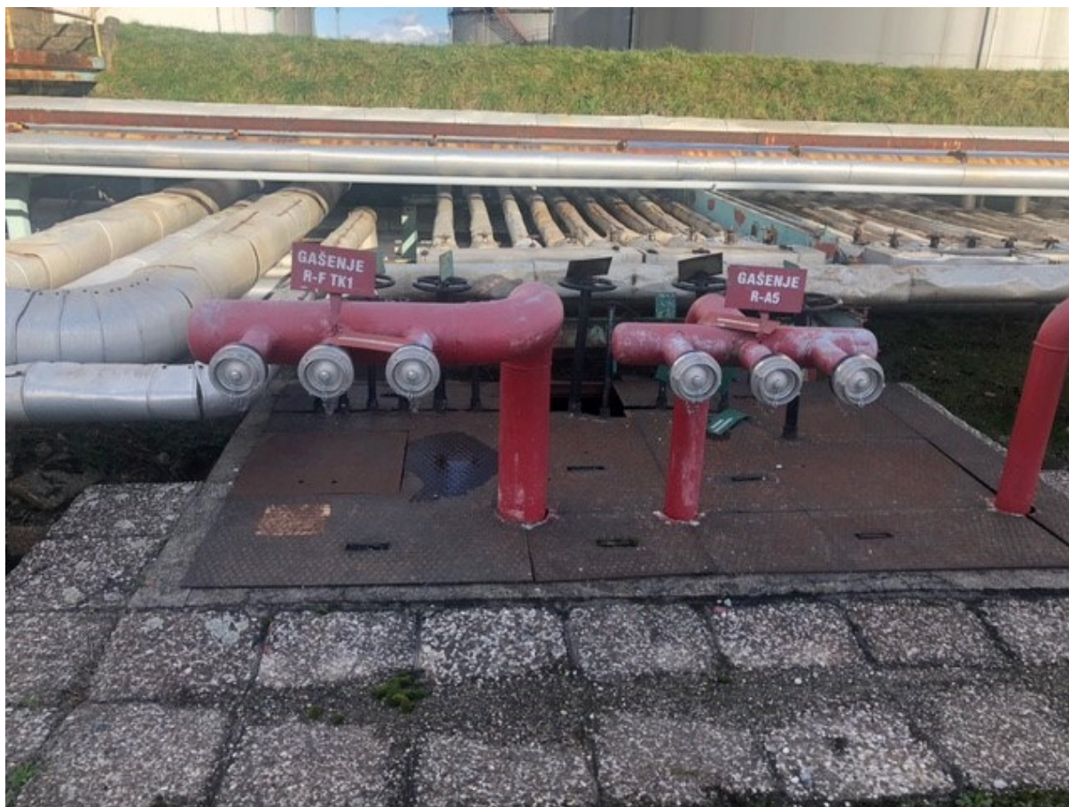
Slika 6. Polustabilni sustav za gašenje spremnika [7]
