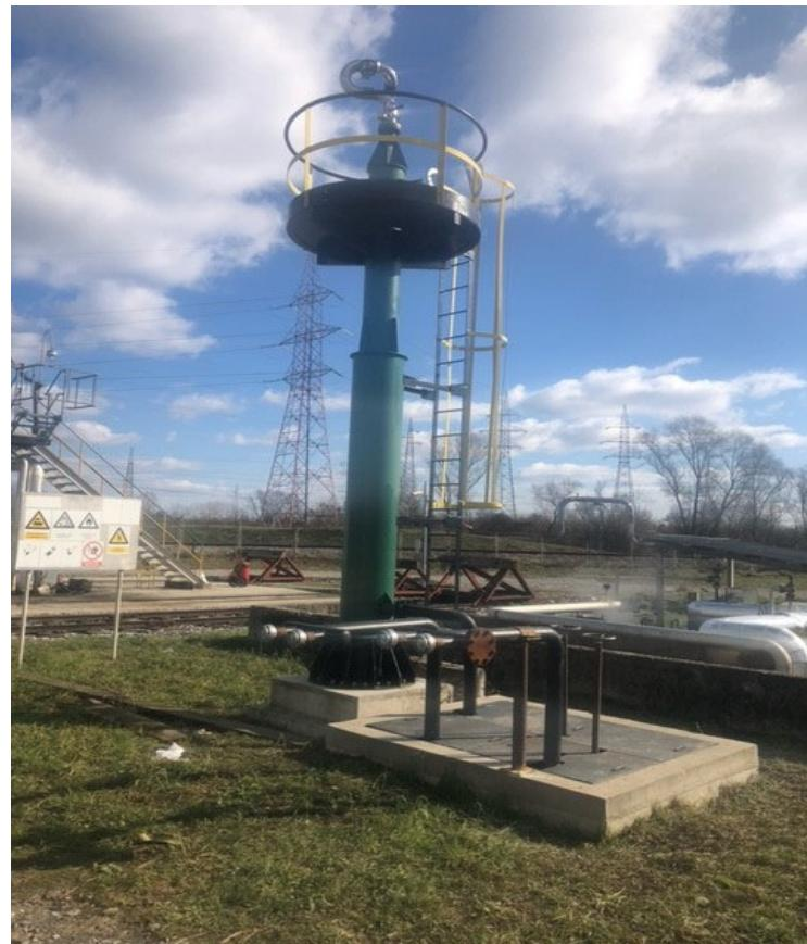
*Slika 11. Stabilni bacač voda/pjena na MM2 [7]*
