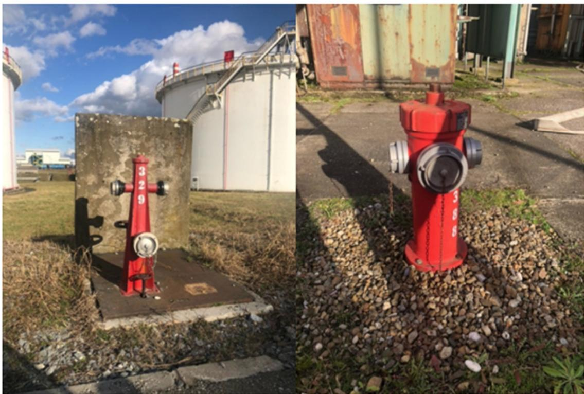
*Slika 17. Vanjski nadzemni hidranti "RNS" i "Juring" [7]*
