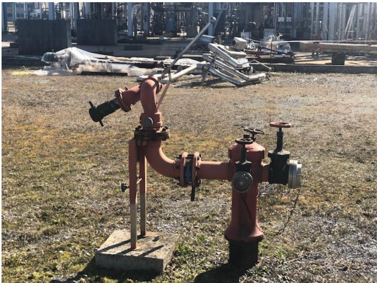
*Slika 12. Stabilni bacač vode na SRU [7]*
