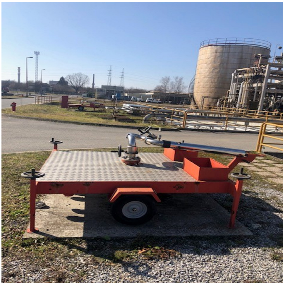
Slika 14. Mobilni bacač voda/pjena tip "Juring" na KP-6 [7]
