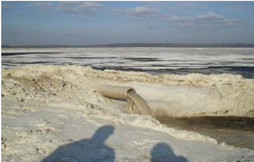
Slika 10: Prikaz ispuštanja fosfogipsa na odlagalište
