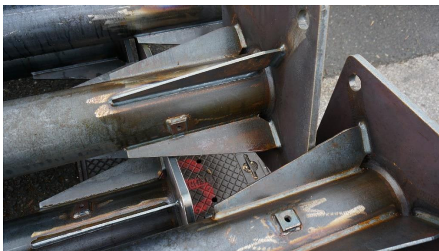
Slika 58. Primjeri pravilno izvedenih prodora na "stopi" rasvjetnog stupa [7]
