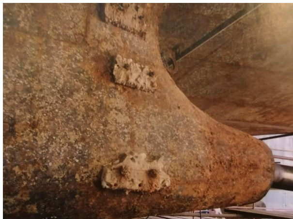
Slika 6. Opća korozija podvodnog dijela brodskog trupa [1]
