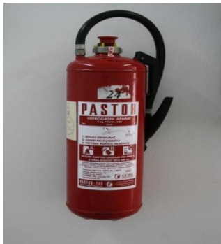
Sl.2.6.3.1. Aparat za gašenje prahom (S), 9kg
