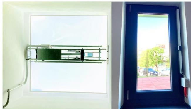
Slika 9. Automatski sustav odimljavanja (otvor za odimljavanje) [1]
