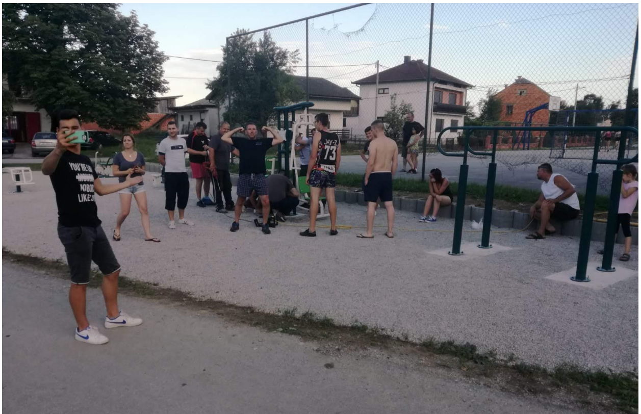
Slika 14. Volonteri postavljaju fitness sprave u sklopu projekta „Fitness pod vedrim nebom“
