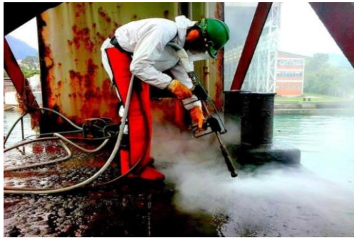
Slika 20: Čišćenje površine mlazom vode [26]
