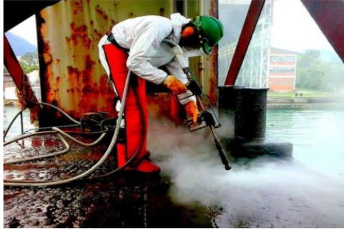
Slika 20: Čišćenje površine mlazom vode [26]
