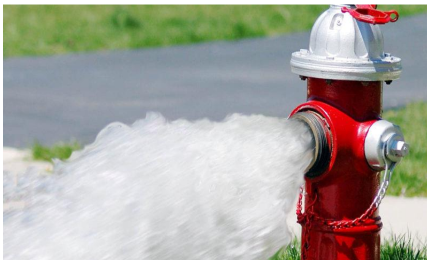
Sl. 10. Prikaz nadzemnog hidranta [5]
