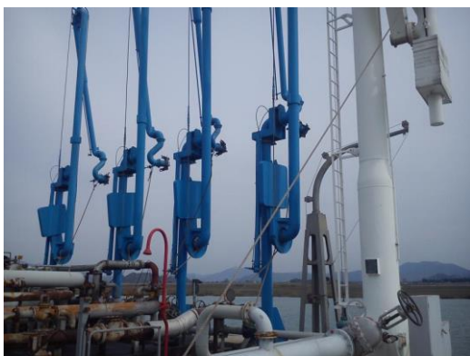
Slika 7. Pretakalište brodova i zglobni utakači.
