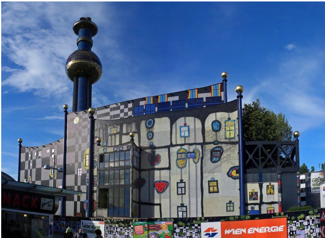
Slika 3 Energetska obrada otpada - spalionica otpada „Spittelau“ u Beču (ANONYMOUS, 2017.)
