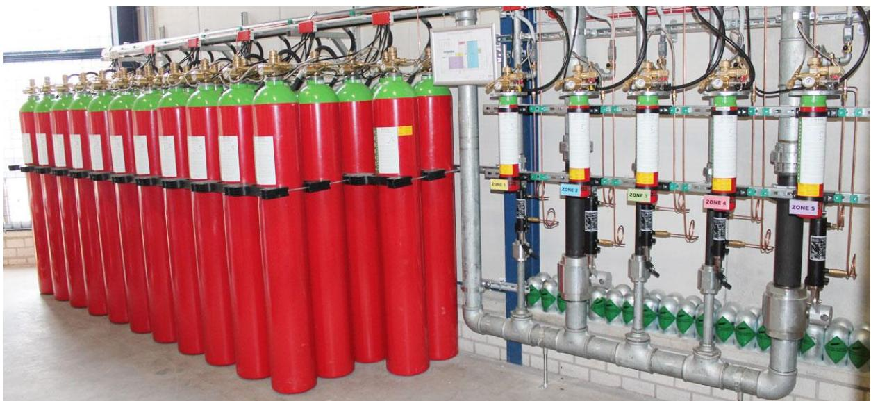
Slika 17. INERGEN protupožarni sustav [16]
