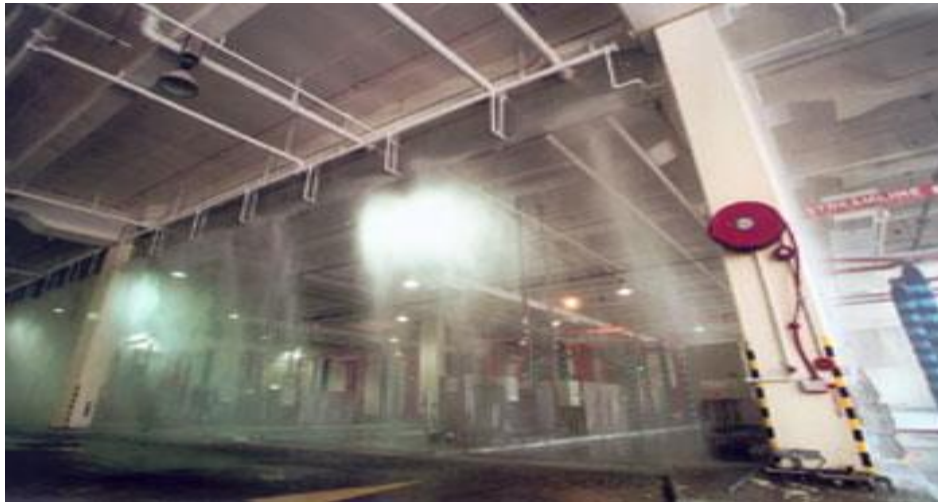
Slika 15. Drencher sustav [15]
