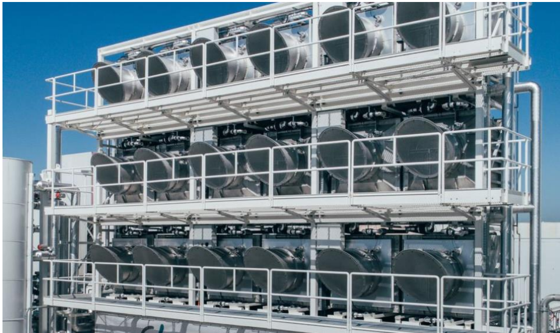
Slika 16: Postrojenje za hvatanje CO 2 iz zraka
