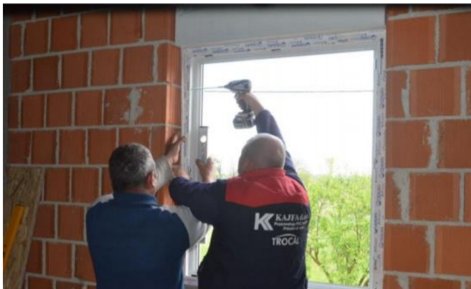
Slika 9 Prikaz montaže PVC prozora
