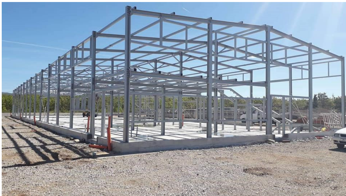
Slika 25. Prikaz montiranih čeličnih profila
