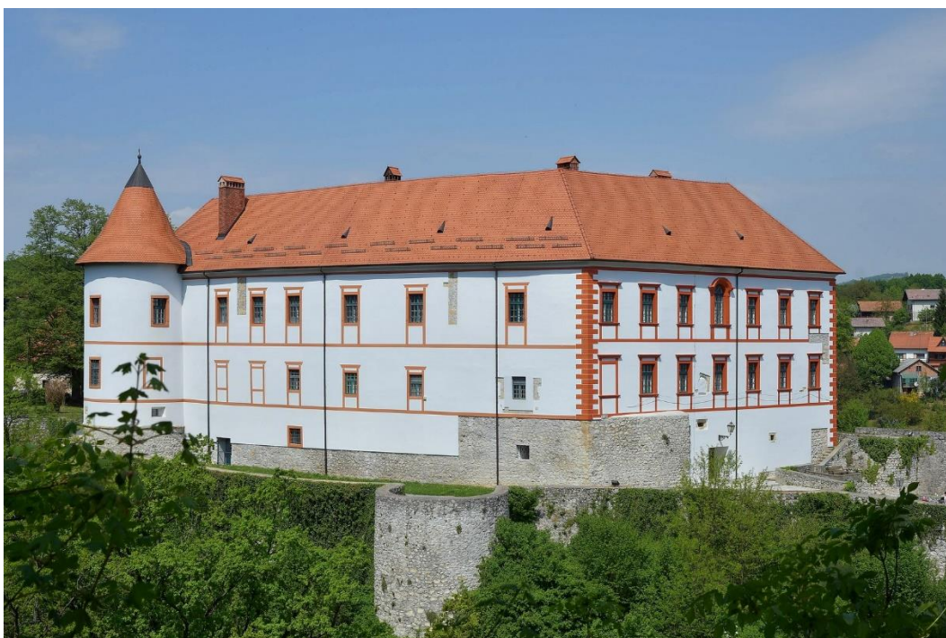
Slika 23: Obnovljeno istočno i južno krilo
