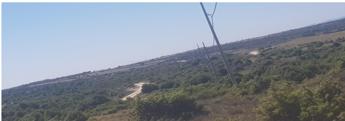
Slika 11: Kablirani dio dalekovoda na Cresu
