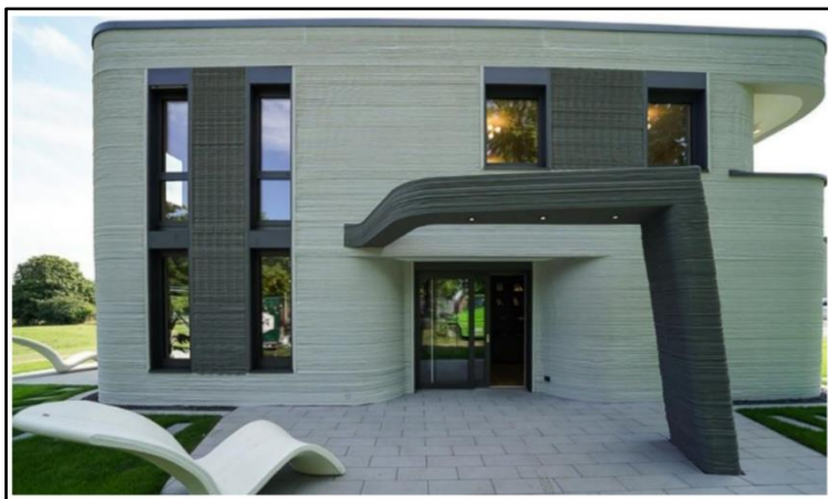
Slika 30. Kuća izgrađena pomoću aditivne tehnologije [33]
