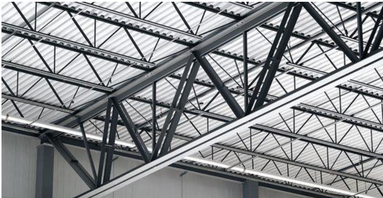
Slika 7. Rešetkasta konstrukcija krova hale [25]
