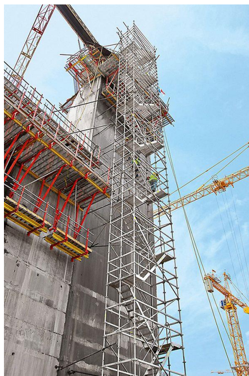
Slika 3. Dogradnja Panamskog kanala – skela [26]
