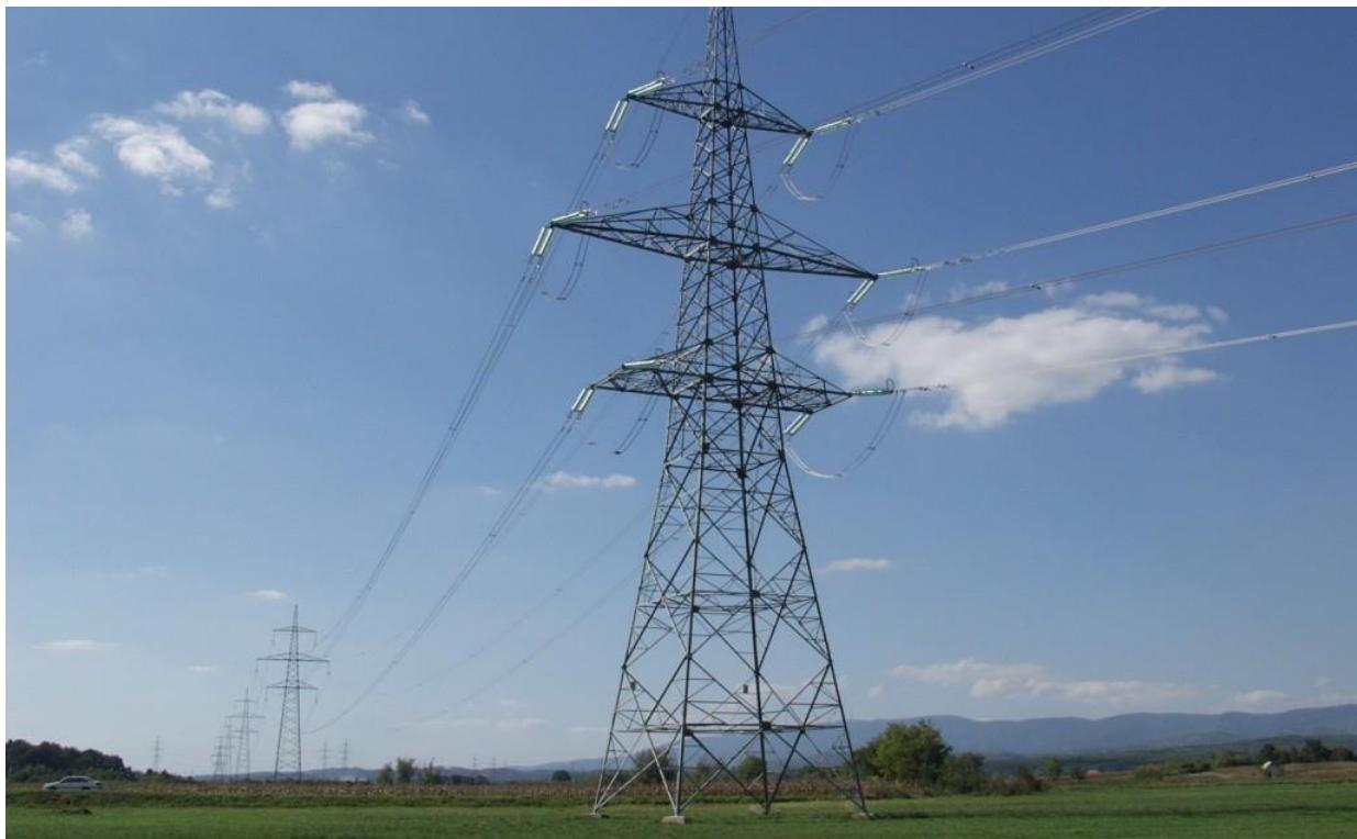
**Slika 4.** Dalekovod izrađen kao rešetkasta konstrukcija [21]
