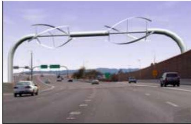
Slika 16 - Horizontalni tip Darrieusove vjetroturbine [4]
