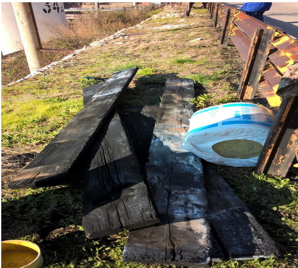
Slika 11. Požarom zahvaćene fosne sa skele iznad mjesta požara [4]
