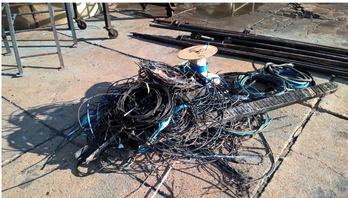
Slika 10. Požarom zahvaćeni razni vodiči instalacija [4]
