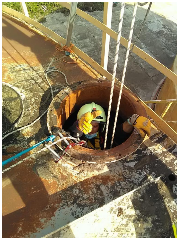
Slika 31. Primjer spašavanja iz dubine i zatvorenog prostora [K.Skrbin]
