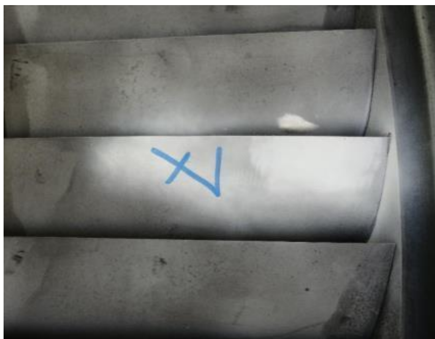
Slika 32. Završna provjera penetrantima nakon popravka
