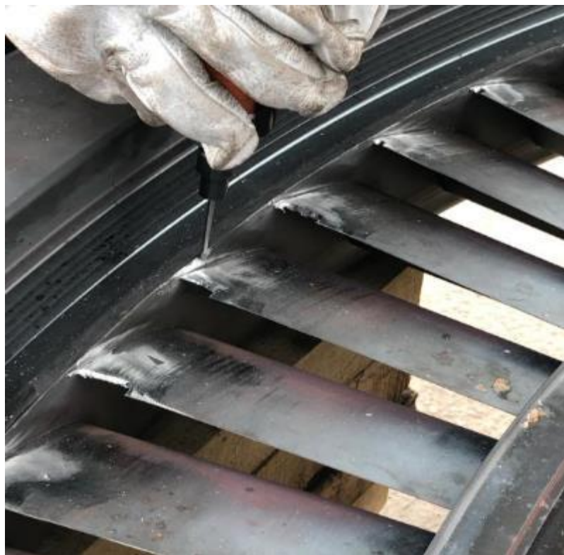
Slika 27. Izrezivanje oštećenih dijelova
