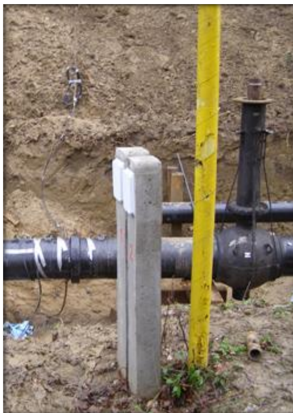
Slika 19. Mjerno mjesto sustava katodne zaštite
