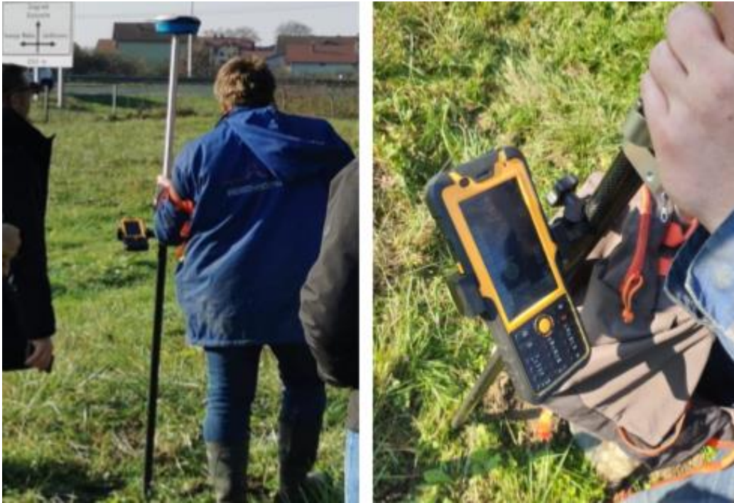
Slika 32. Određivanja trase VT plinovoda
