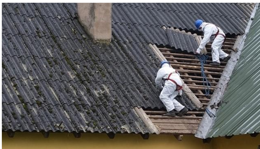
Slika 7. Primjer uklanjanja azbestnog krova [16]
