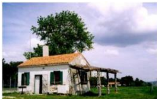
Slika 16. NADZORNA KUĆICA NA CRKVINAMA
